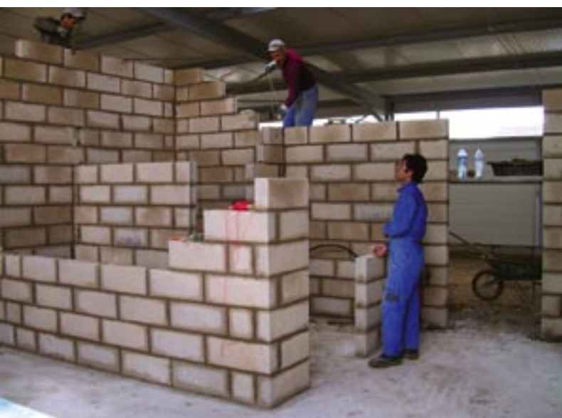
Ill. 15 : Le chantier du Pôle social et environnemental
