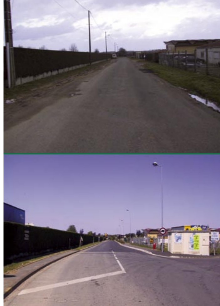
De nouvelles voies de desserte ont été créées en 2004 dans la zone d'activité de Saint-Just-en-Chaussée
